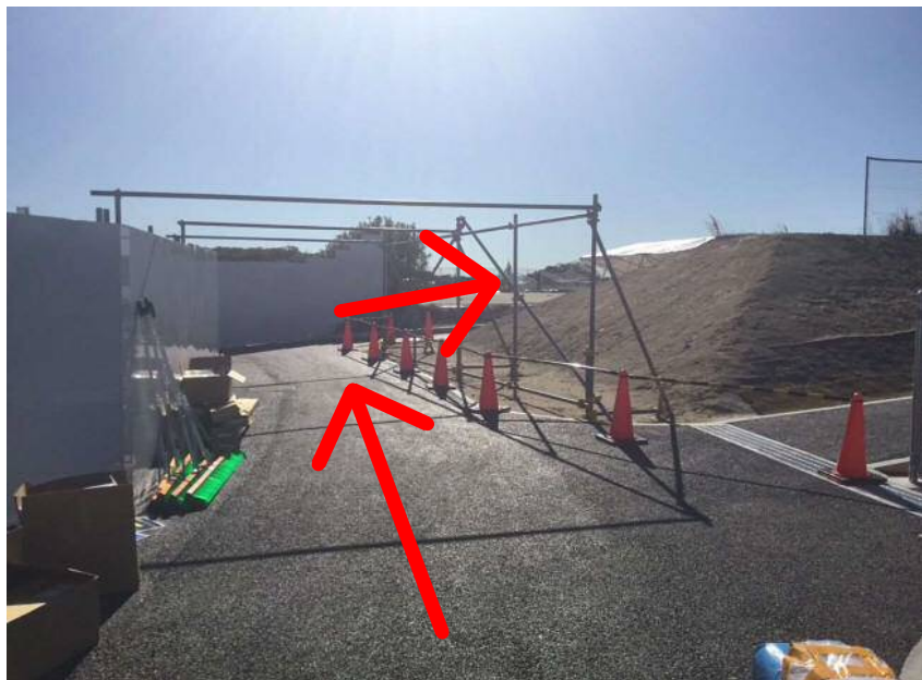
⑤アスファルトの上をグラウンド方向に歩く
