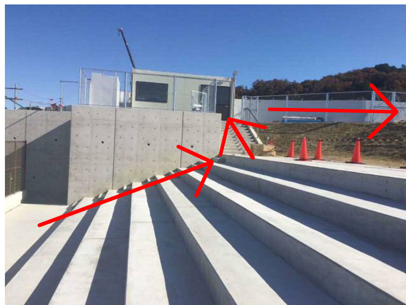
④ 階段を上ったら、左折し小階段で仮クラブハウスを 右折しアスファルトの上を歩く
